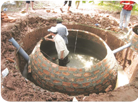
Hình 9.7 Mô hình hầm Biogas được các hộ chăn nuôi áp dụng tại nhiều địa phương trên địa bàn tỉnh.
