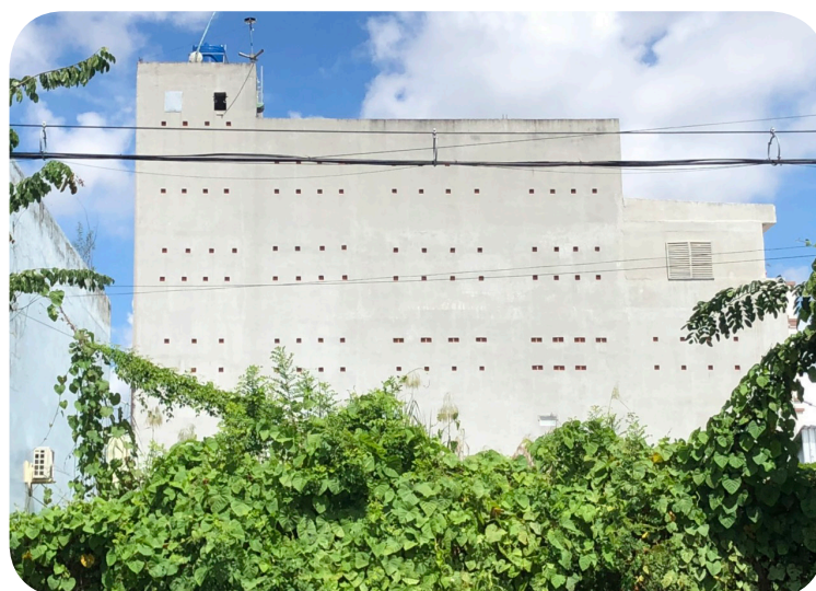
Hình 9.2. Nhà nuôi chim yến sử dụng thiết bị phát âm thanh dẫn dụ, gây ô nhiễm tiếng ồn
